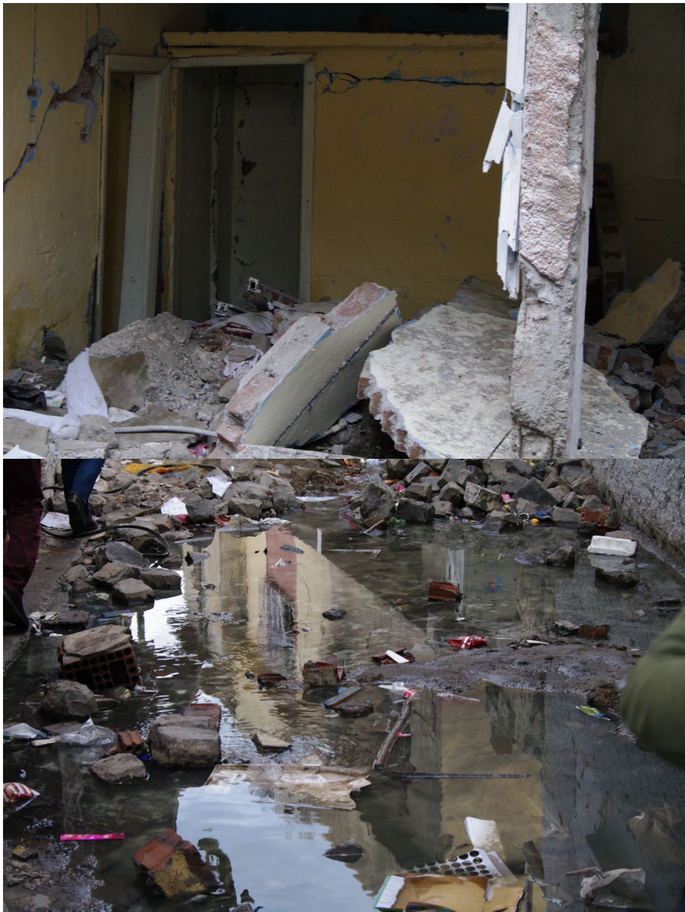
Les canalisant détruites par des bombardement continue de fuir à même le sol de la ville, formant un petit ruisseau dans les ruelles.
